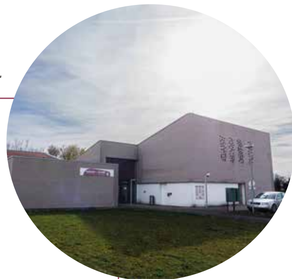
Maison de Santé intercommunale à Ancerville.
